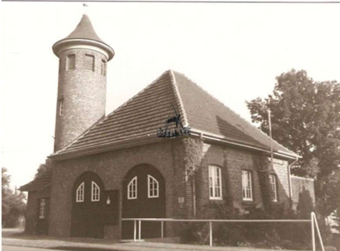
Spritzenhaus an der Heidener Straße in Groß Reken
